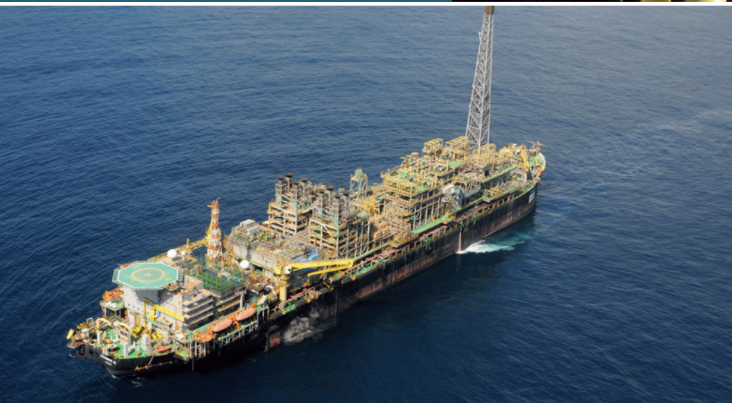
Elementos do GruMeC realizam exercício na Plataforma P-43
