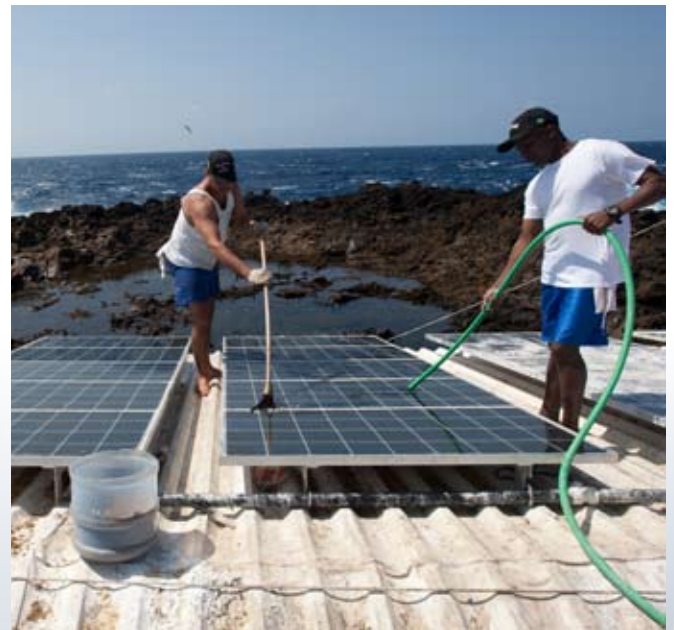
Limpeza dos painéis fotovoltaicos da Estação Científica
