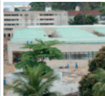
Situação atual das obras da PNN
