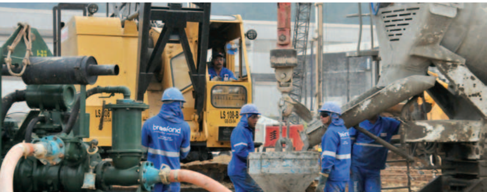
Obra de construção da Unidade de Fabricação de Estruturas Metálicas
